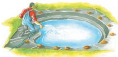
4_Riempite d'acqua (dopo aver steso il telo)
