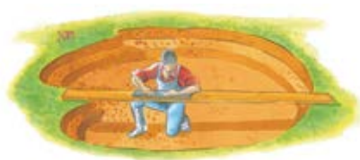
3_verificate la "bolla"
